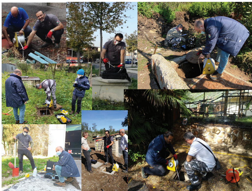
Fig. 1: Attività di censimento e monitoraggio delle stazioni nella Rete di Monitoraggio delle Acque sotterranee di Roma Capitale.
